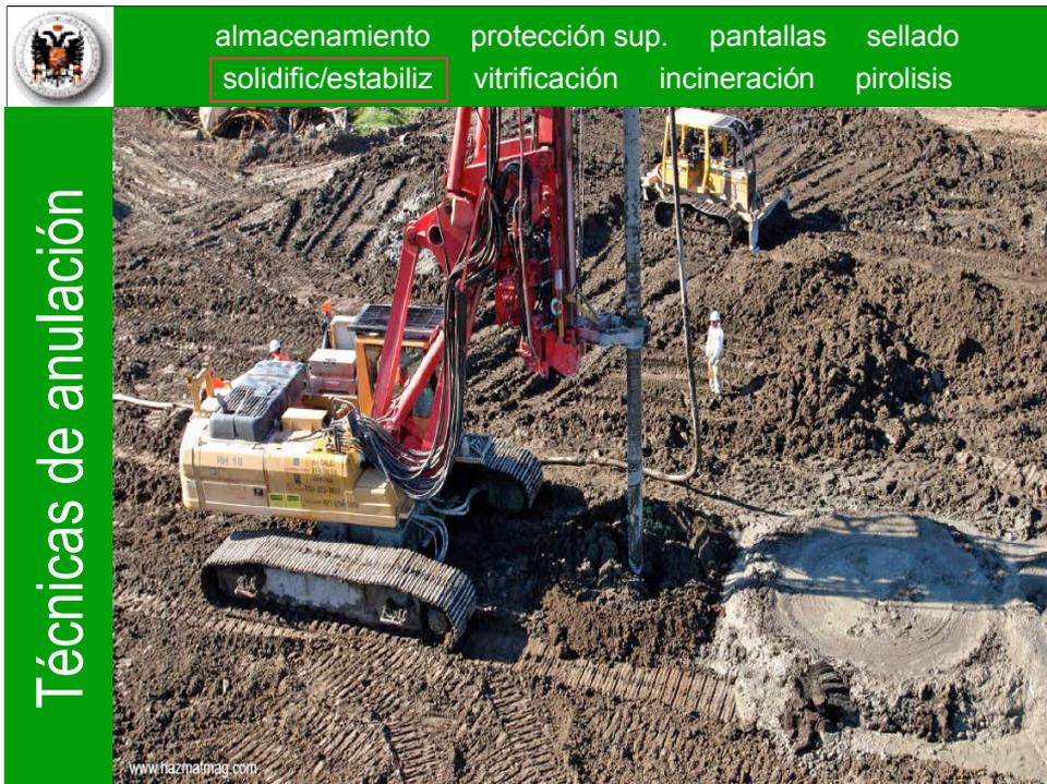
In situ, inyección del agente por perforadora que lo mezcla con el suelo en un radio de 2 a 3 m.
